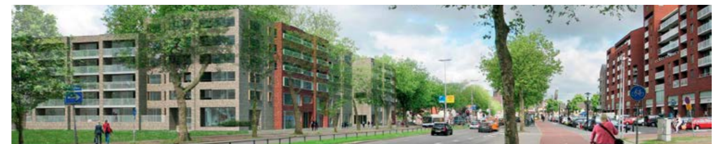
Aquatherm in nieuwbouw De Gravin, Utrecht.
