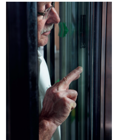
Profiel komt niet meer uit de sponning.
