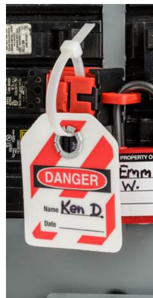
Beveiliging met kabelbinder en/of hangslot
